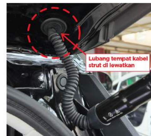
9. Lepas penutup karet dari posisi yang ditunjukkan untuk jalur kabel strut.
